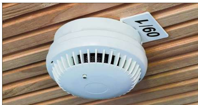
Ein Rauchmelder an einer Zimmerdecke Foto: Feuerwehr Rottweil
